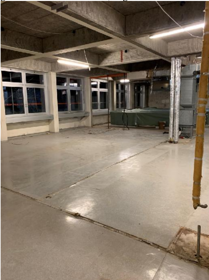
Neubau Ebene 2 mit Blick Richtung Küche
